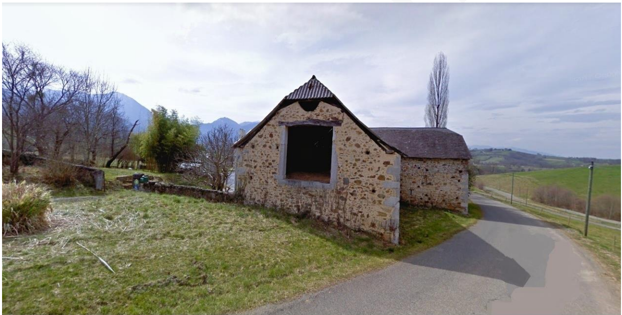
Vue du bâtiment / Source : PLU de la commune d'Asson
