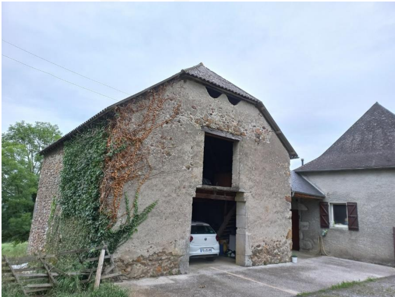
Vue du bâtiment dit Courades (source : Commune d'Asson)
