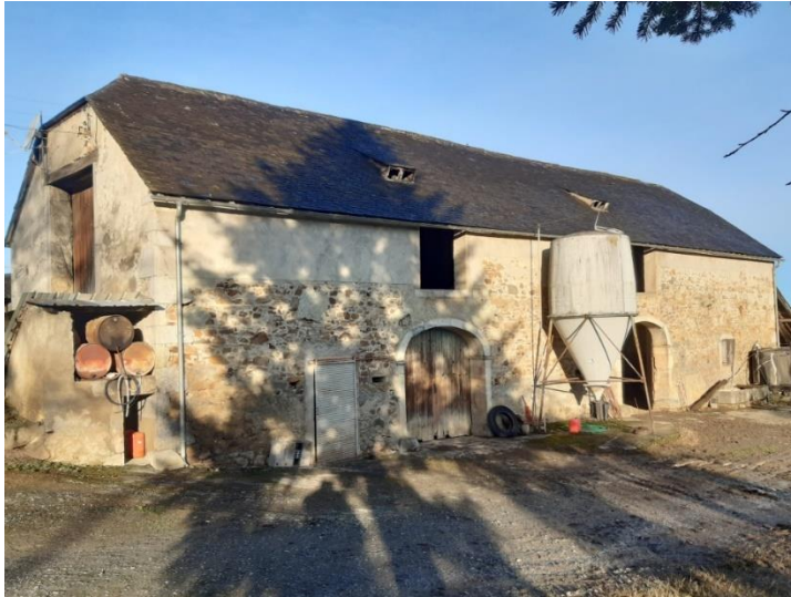
Vue du bâtiment dit Laborde-Turon (Source : Commune d'Asson)
