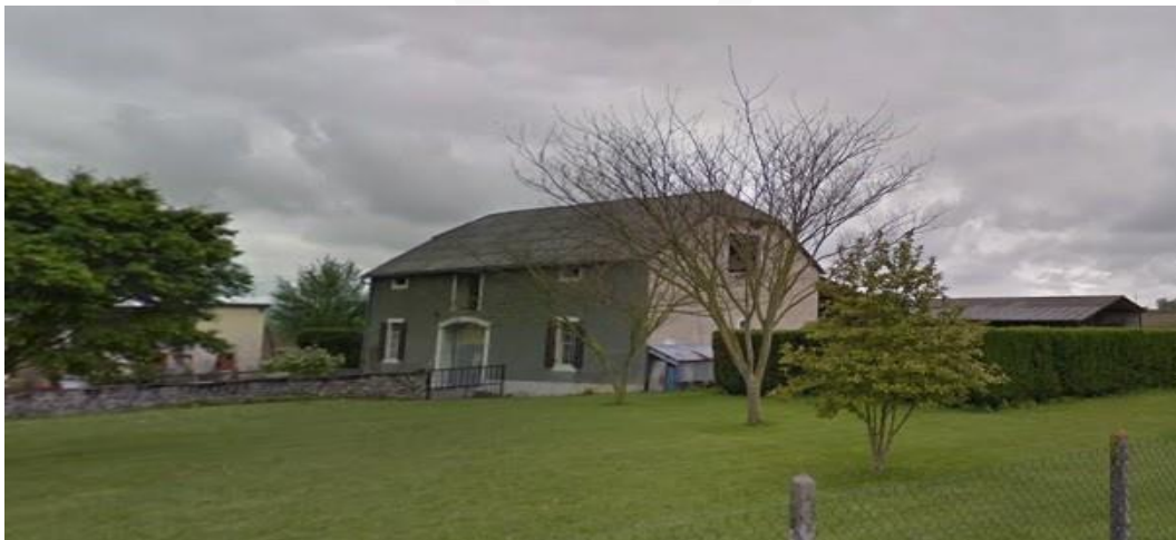
Vue du bâtiment / Source : PLU de la commune d'Asson
