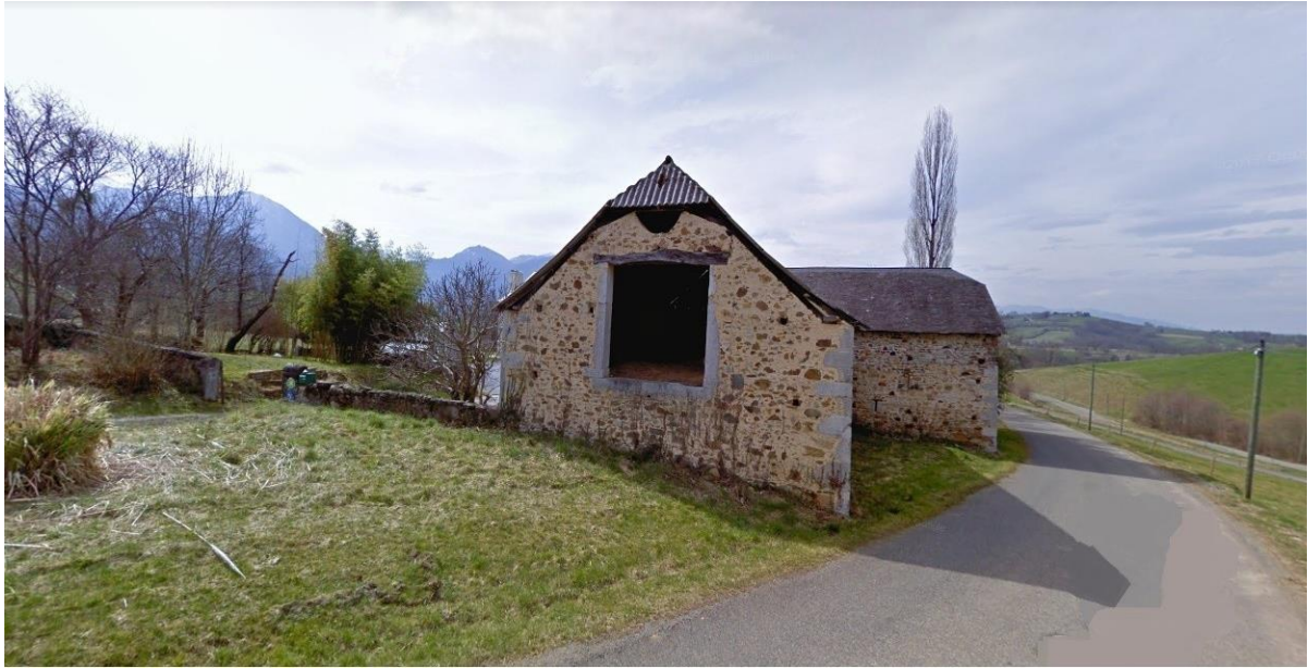
Vue du bâtiment / Source : PLU de la commune d'Asson
